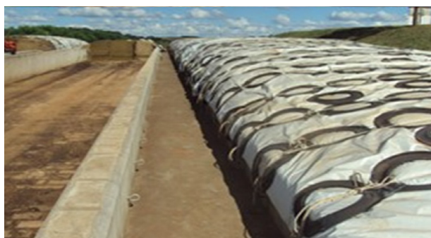
Figura 26 - Proteção silo com pneus.
