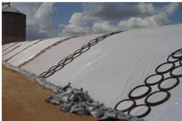
Figura 24 - Junção de lonas e distribuição de pesos vedação do silo.
