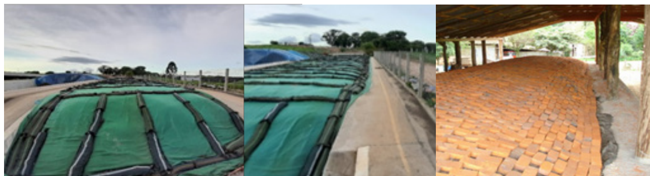
Figura 27 - Proteção silo com sacos de polidas/areia e tijolos.
