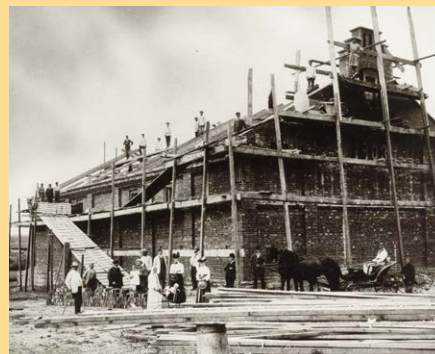
Працівники використовують дерев'яний пандус для транспортування будівельних матеріалів на дах майже завершеного складу. Співробітники насолоджуються вільним часом на садовій вечірці.
